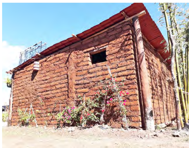
Maison construite en briques de sargasse (Sargablocks) par Omar Vazquez Sanchez au Mexique, 2019 © BlueGreen
